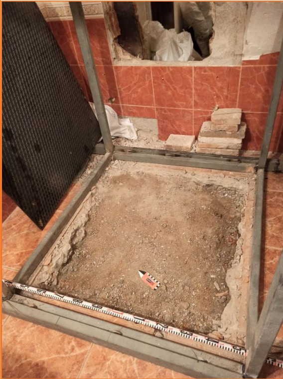
Foto 5. Fotografia presa un cop extret el paviment de rajoles actuals del lavabo del local comercial, UE 1, i l'anivellació UE 2.
